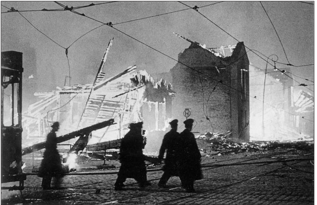
Kiel 1943: Die Verursacher und die Folgen des Krieges schon vergessen?
